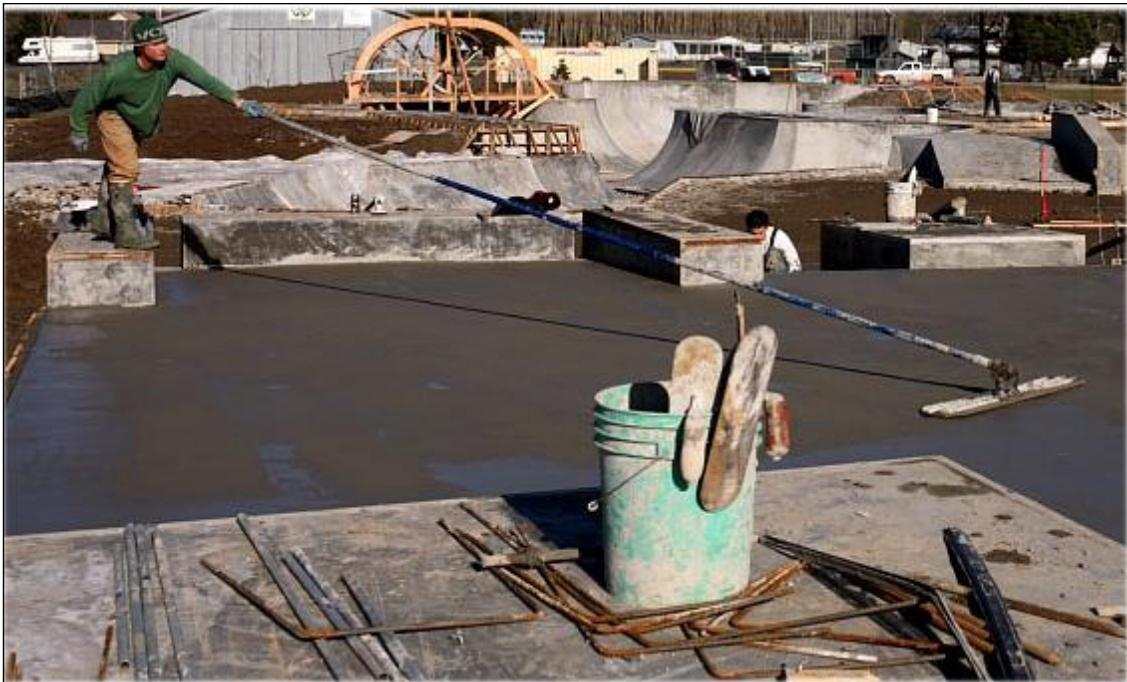
K. Se considera un equipo especializado formado por no menos de 5 operarios para realizar el trabajo con llanas manuales en paños 3 x 3 mts curvos e inclinados.
